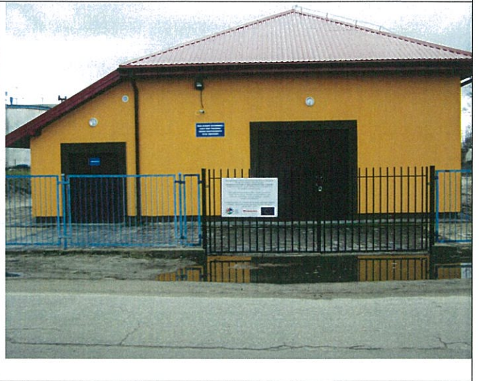
Stacja wodociągowa po przebudowie
