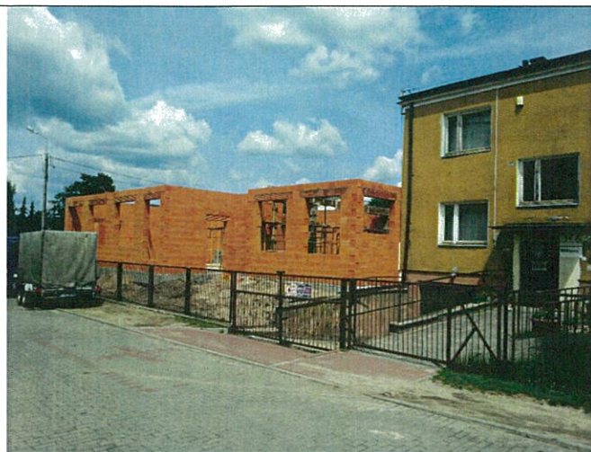
Budynek NZOZ w rozbudowie
