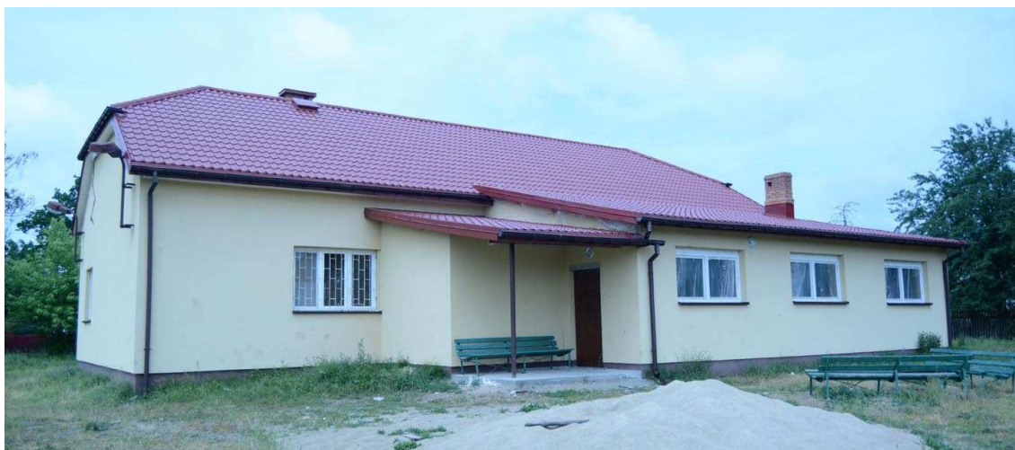
Fot 3. Elewacja południowa budynku
