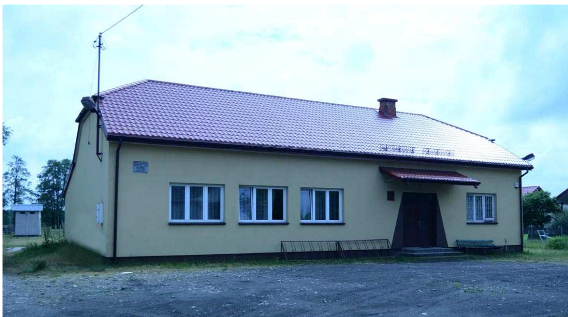
Fot. 2. Elewacja północna budynku
