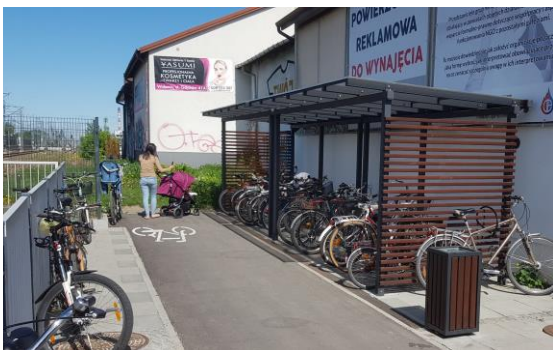
Rys. 7.2 Zadaszony parking B+R w Wołominie
