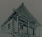
rekonstrukcja domu podcieniowego przy Rynku osieckim z XVIII wieku
